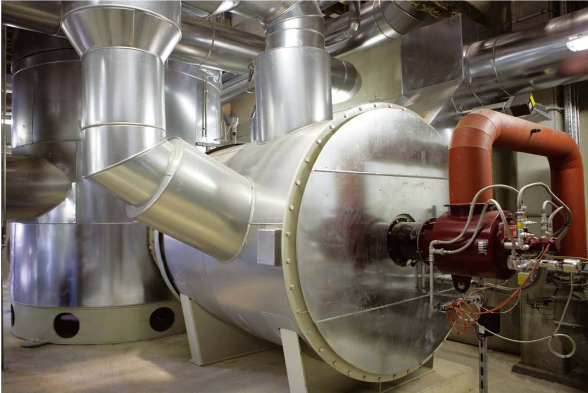
Nachbrennkammer mit Brenner (Unterer Teil)
